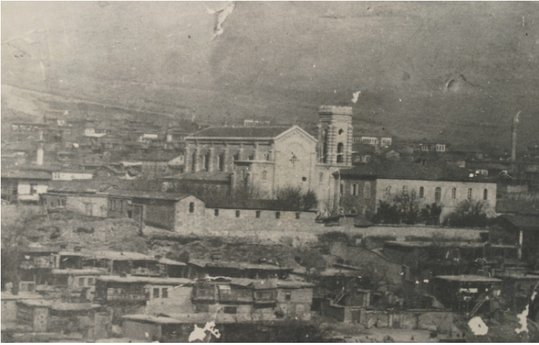
İt Tepesinde Abarabaşı Kilisesi (Beli Kendirliiler Kilisesi) Fransız Katoliklerine ait bu kilise oldukça muhkem bir yerde sağlam ve mücessem yapıydı. Harpte büyük fedakârlıklara rağmen düşürülememiş ve zaferden sonra teslim alınmıştı.
